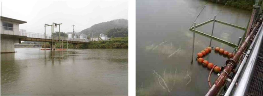
図-1 河内ダムのマイクロバブル発生装置
