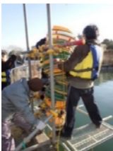
図-2 沈降筒設置状況
