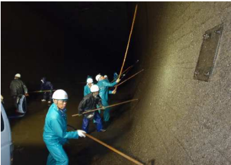
写真－3 人力作業による水虫除去状況
