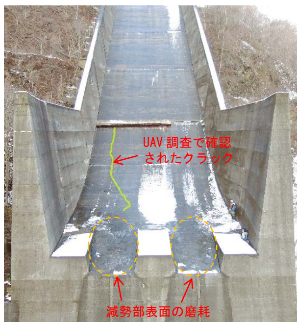
写真-4 洪水吐き急勾配部の状況
