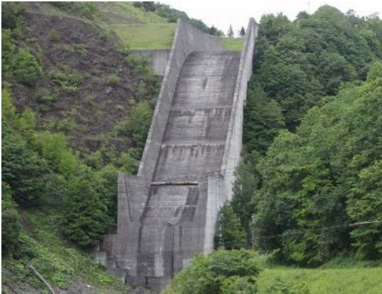
写真-1 洪水吐き急勾配水路部
