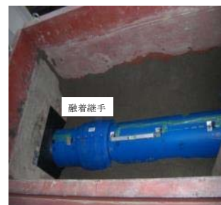
写真-2 融着継手付 埋設状況（呼び径200）
