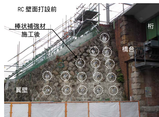
写真-1 橋台翼壁部 棒状補強材設置状況
