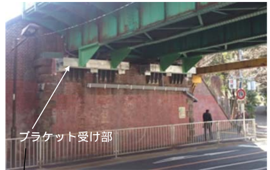
写真-2 ブラケット補強設置状況
