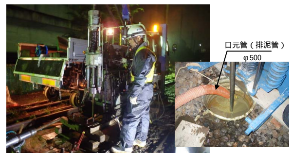
写真-4 柱状改良体造成状況
