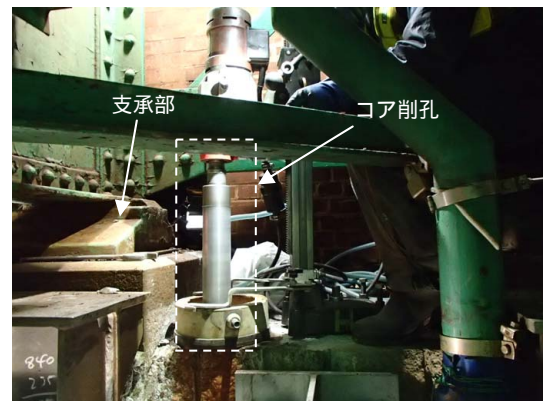
写真-3 橋台背面補強 補強鉄筋設置状況
