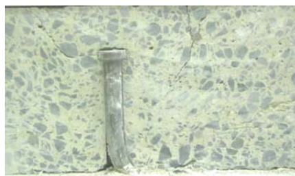
写真-1 試験体切断面(2-3) (コンクリート破壊)
