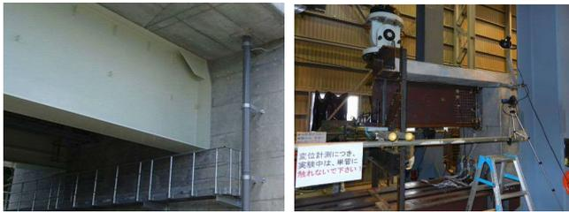
写真-1 支圧板方式の剛結部構造概要
