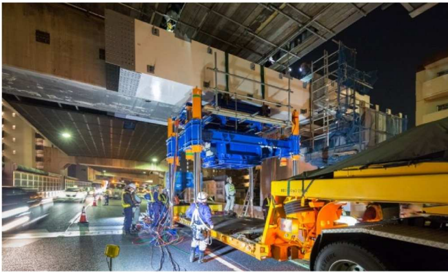
写真-2 ジャッキアップ状況
