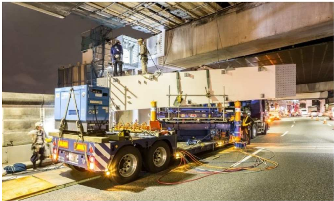
写真-1 ターンテーブルによる90° 回転状況
