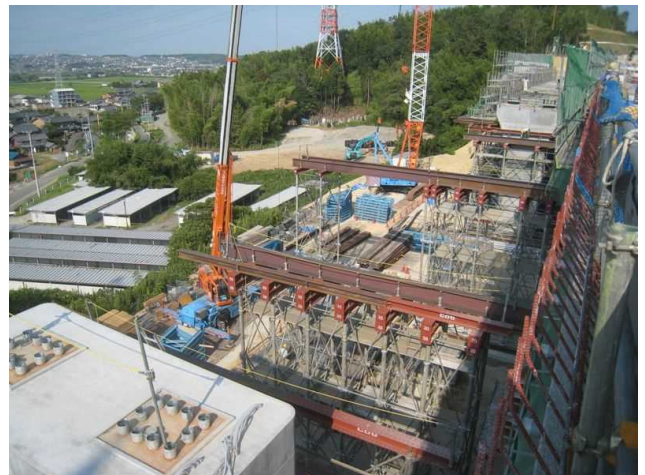
写真4 上り線北側のクレーンヤード
