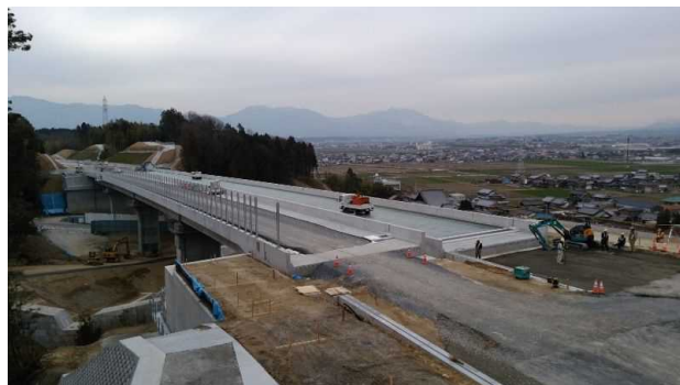
写真1 A1側より橋面を望む
