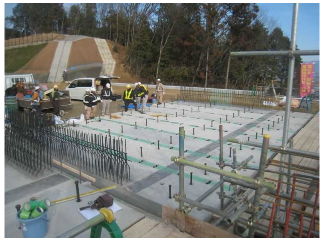
写真3 プレキャスト延長床版(A2側)
