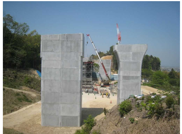
写真2 A1側よりP1, P2橋脚(SEED型枠施工)を望む
