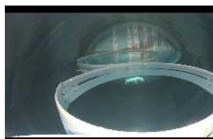
写真-3 制振装置浮遊の様子
