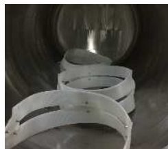
写真-2 制振装置設置の様子
