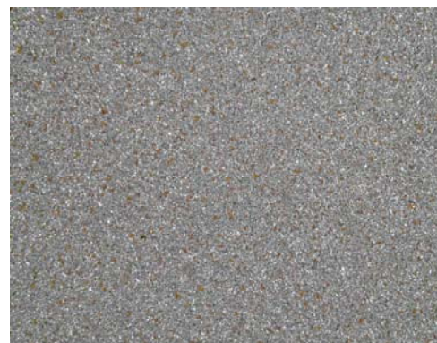
図1 点錆の発生状況（拡大撮影）
