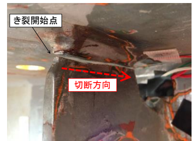
写真-4 施工後の状況
