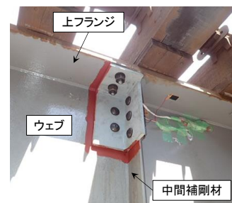
写真-2 提案された3面当板工法
