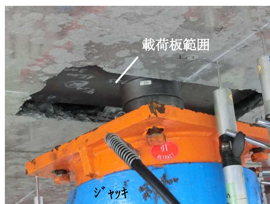
図-9 押し抜き状況
