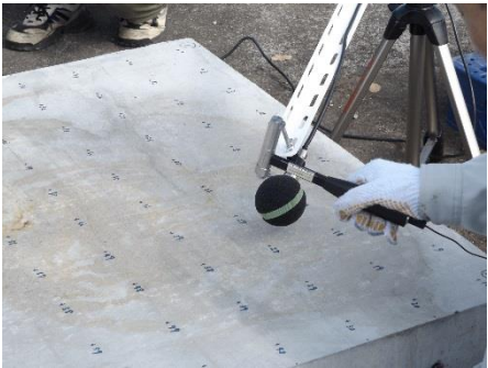
写真 1 打音試験の様子
