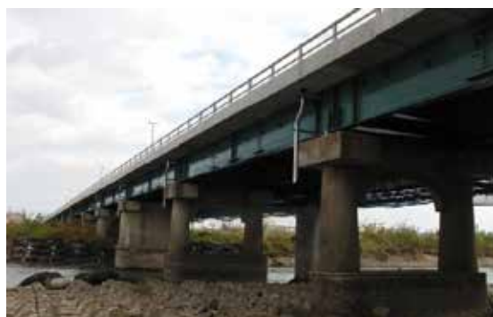
写真-1 試験橋梁
