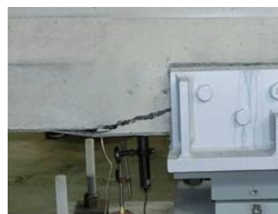
図-6 主桁損傷状況
