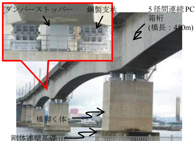
図-1 現況の北浦港橋りょう
