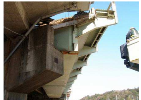
図-1 斜角桁の回転状況
