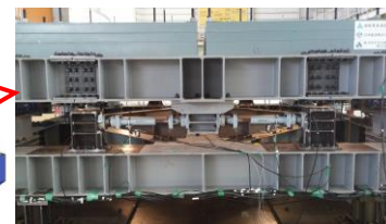
写真-1 摩擦ダンパー設置状況
