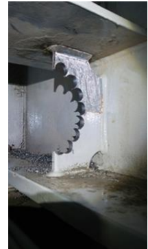
写真-1 切り欠き施工状況
