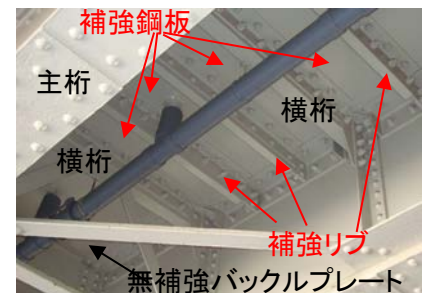
図3 下支え工法による補強事例
