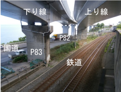
図-2 下り線 P83 橋脚付近の状況
