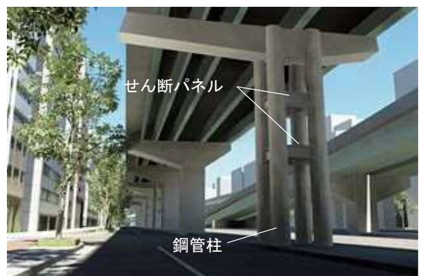
図-1 鋼管集成橋脚 (西船場 JCT 完成イメージ)
