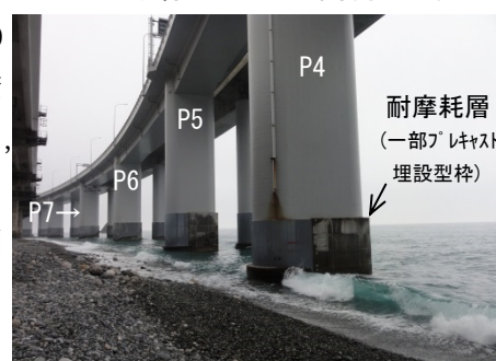
写真-1 上り線 P4～P7 区間現地状況
