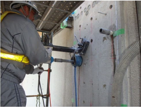
写真2 コア削孔状況
