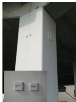
③実高架橋
