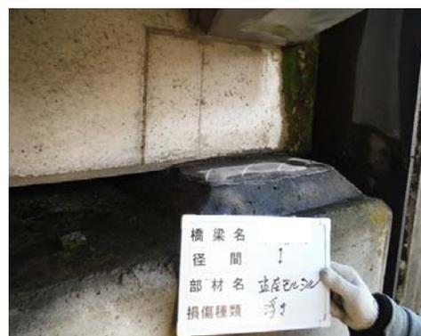
写真 1 沓座モルタルのうき損傷
