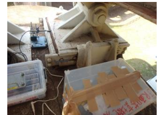
写真-7 上沓の可動量測定状況
