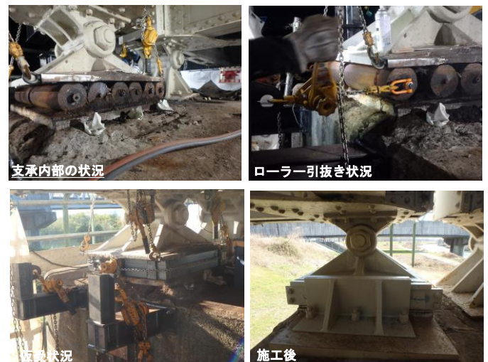
写真-3 ローラー支承の施工状況
