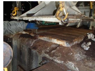
写真-6 上下沓の磨耗状況/ローラー間の塵埃堆積状況
