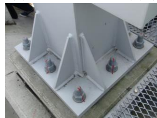
写真-2 支柱基部
