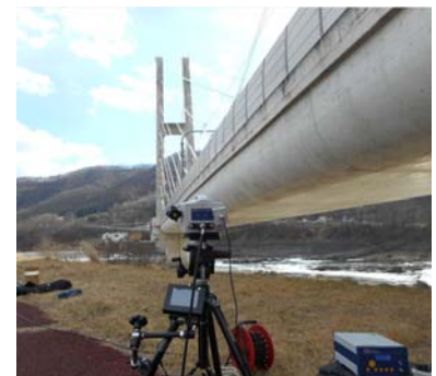
図 2 斜材の非接触振動測定状況例
