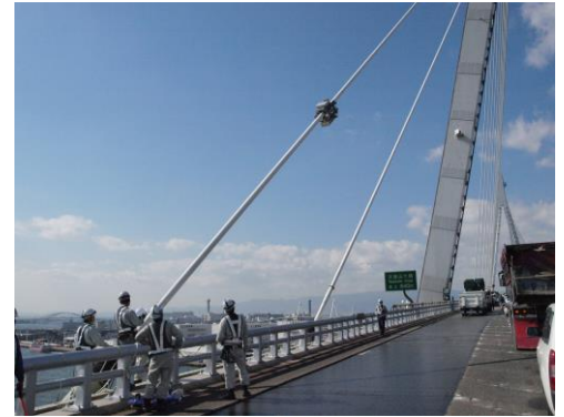
写真-3 点検状況
