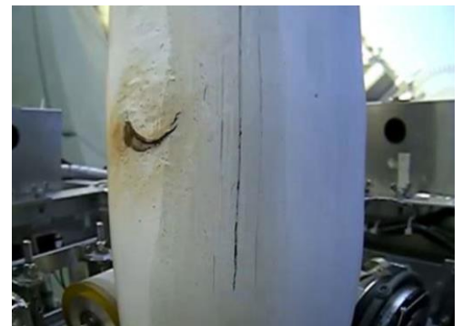
写真-4 グラウト孔後埋め材の浮き
