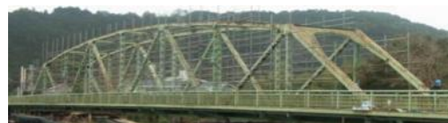
図-1 対象橋梁の写真
