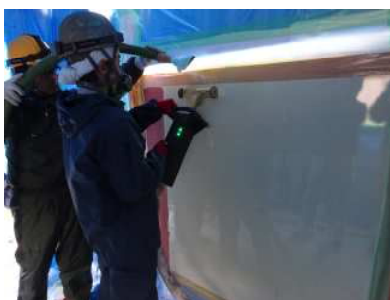
写真-3 IH工法施工時
