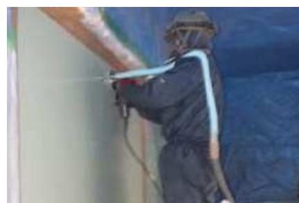
写真-5 剥離剤工法剥離剤施工時
