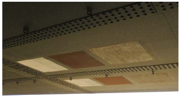
写真-1 下フランジ下面の試験施工面の状況
