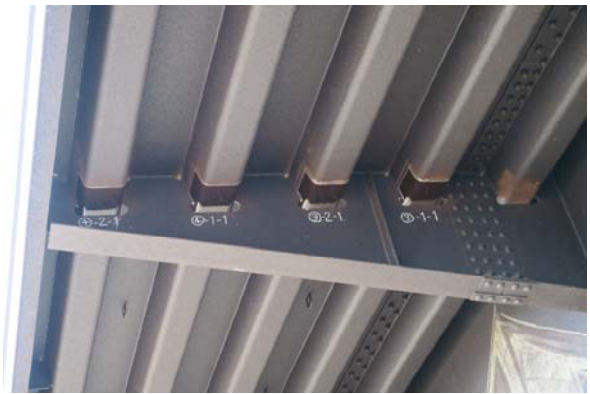
写真-2 Uリブ下面の試験施工面の状況
