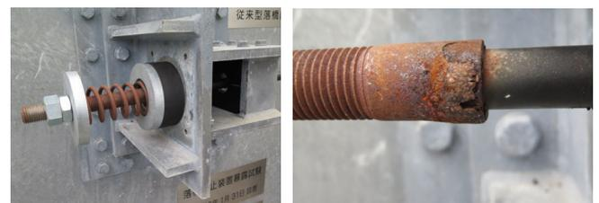
写真-7 従来型落橋防止装置の腐食状況
