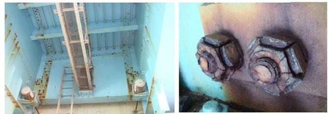
写真1 試験施工対象箇所とナット部腐食状況
