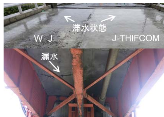
写真-6 補修施工後の漏水の有無状況
