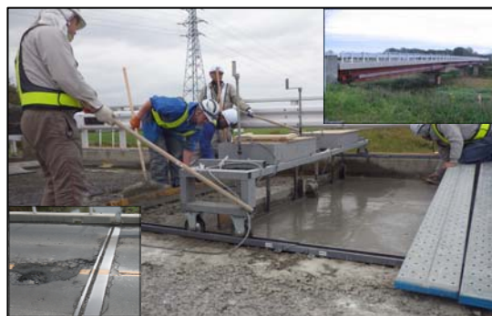
写真-4 J-THIFCOM 打設状況
