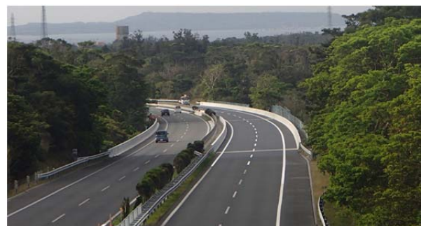
写真 - 3 床版取替え完了
