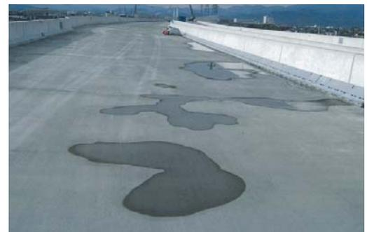
写真-1 引渡し前の床版面滞水状況
