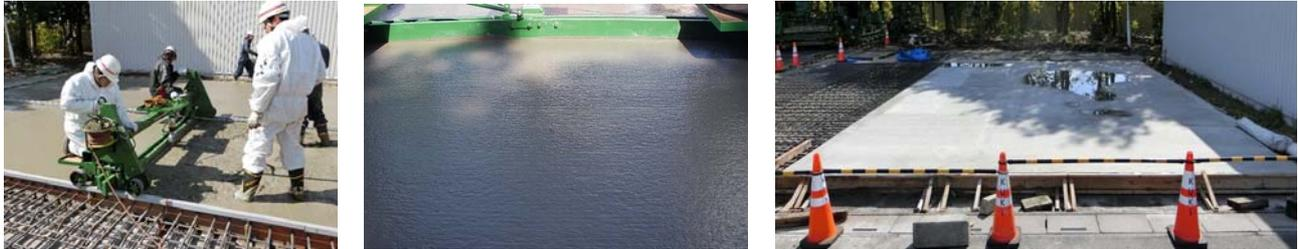
写真-5 試作仕上げ装置
