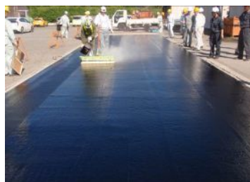
写真-1 アスファルト系接着材塗布状況 (アスファルトコンパウンド)
