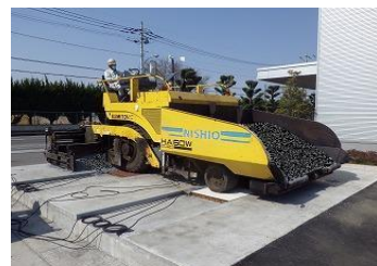
写真-2 せん断力測定状況
