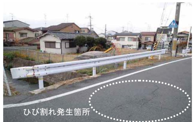
写真-6 舗装のひび割れ状況
