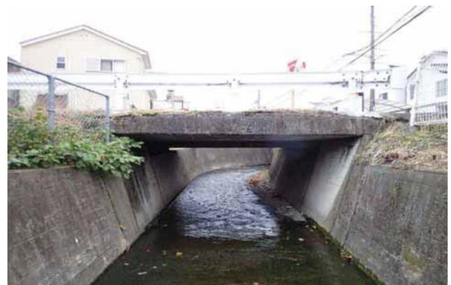
写真-3 下流側のRC床版橋部の側面写真
