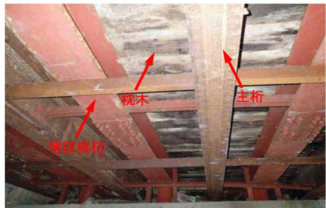
写真-5 床版に転用された枕木の腐食
