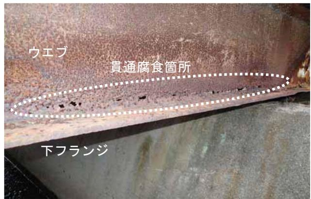
写真-4 鋼桁橋部の外桁の腐食状況
