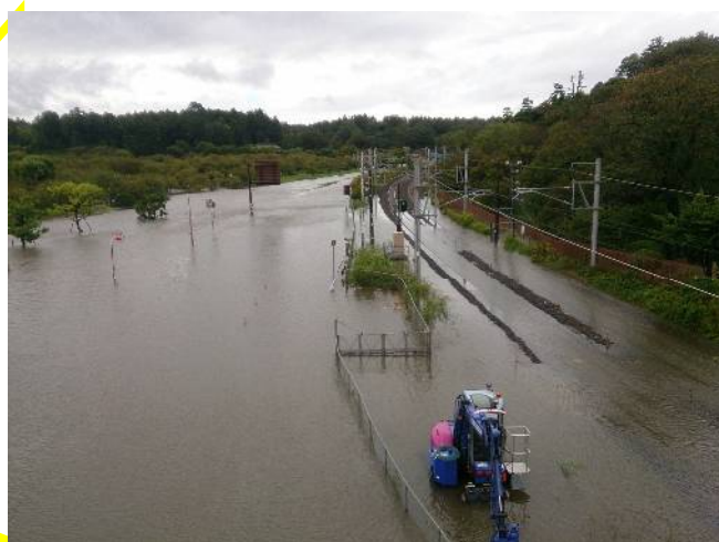
図-2 2014 年 10 月 6 日の冠水被害状況 (茨城県水戸土木事務所 HP)
