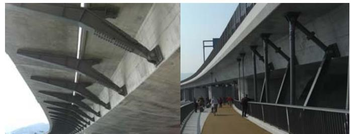
図-6 ブラケットの継手
