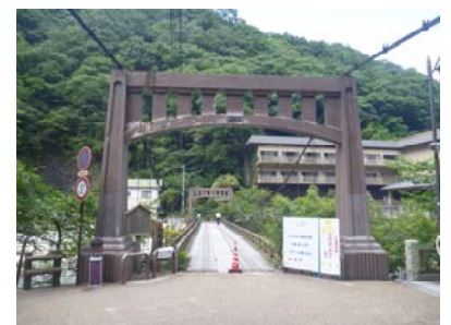
図-1 既設橋の状況
