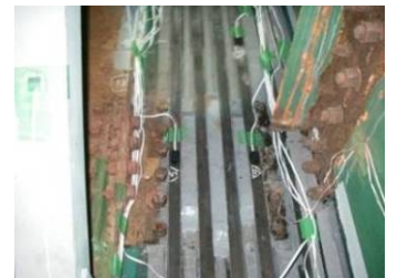
写真-3 CFRP板による補修
