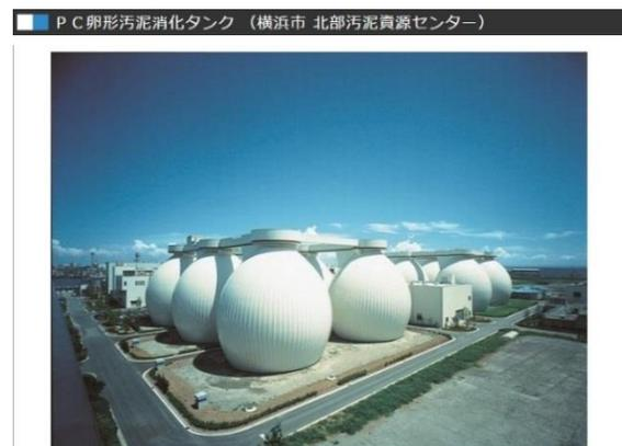
図-2 事例1:PC 卵形汚泥消化タンク
