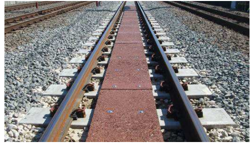
図5 軌道面吸音板を敷設した軌道
