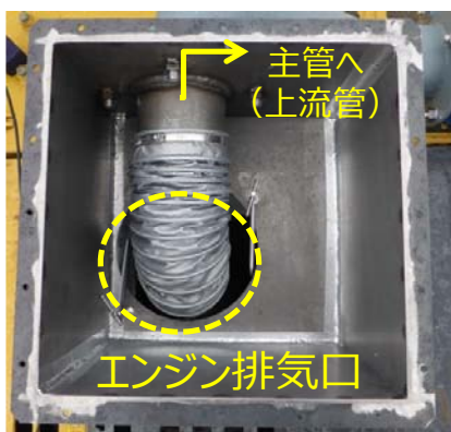
図-5 排気口カバー内部の状況
